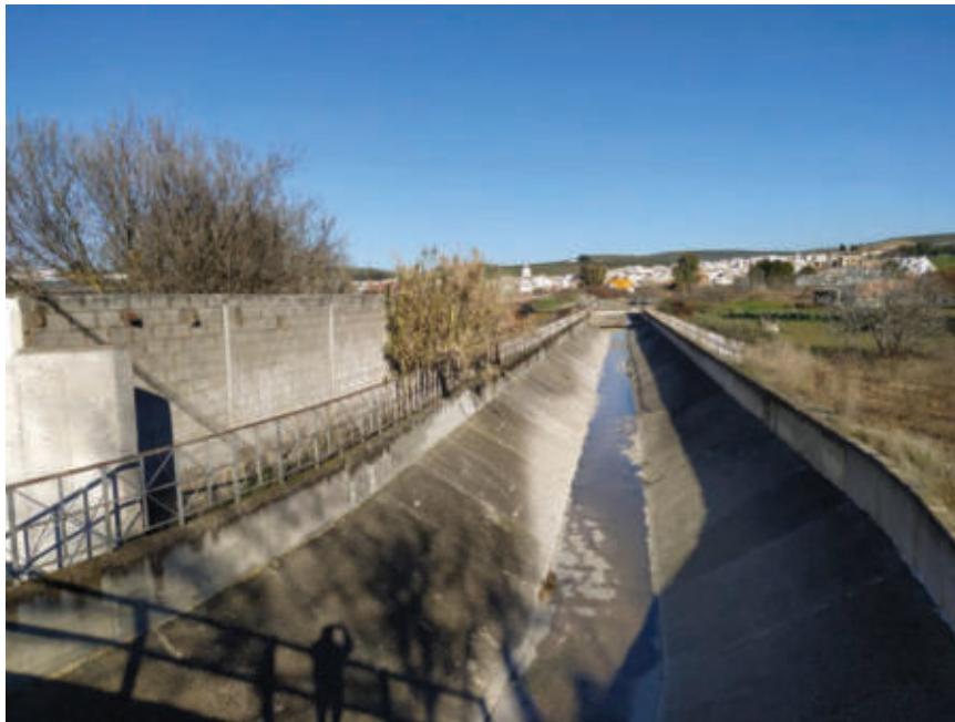
Foto 1. Vista del encauzamiento del Arroyo de las Canteras, al sureste del Sector PP-4.
