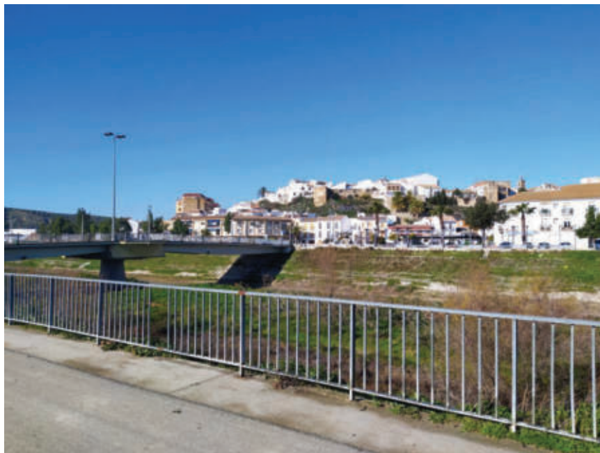
Foto 3. Vista del núcleo urbano de Castro del Río desde el borde norte del Sector PP-4.
